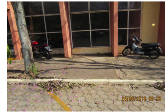
Foto 01 - Vista da Fachada
