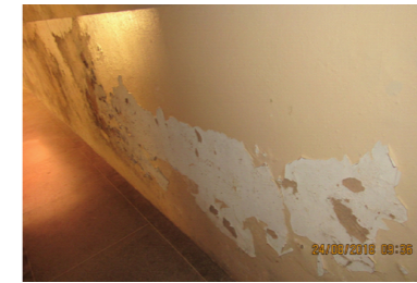
Foto 01 - Vista da Parede Interna
