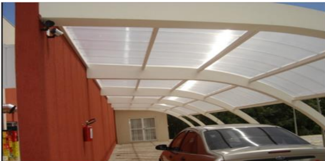
Foto 1 - Cobertura de referência para as coberturas curvas em projeto.
